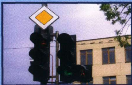
Světelná signalizační zařízení pro řízení silniční dopravy
