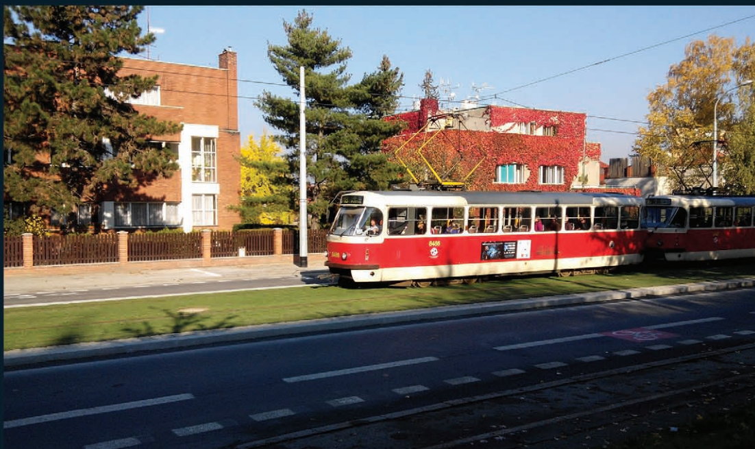
Rekonstrukce tramvajové trati Střešovická
