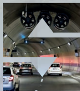
Tunelový komplex Blanka Zkušební provoz
