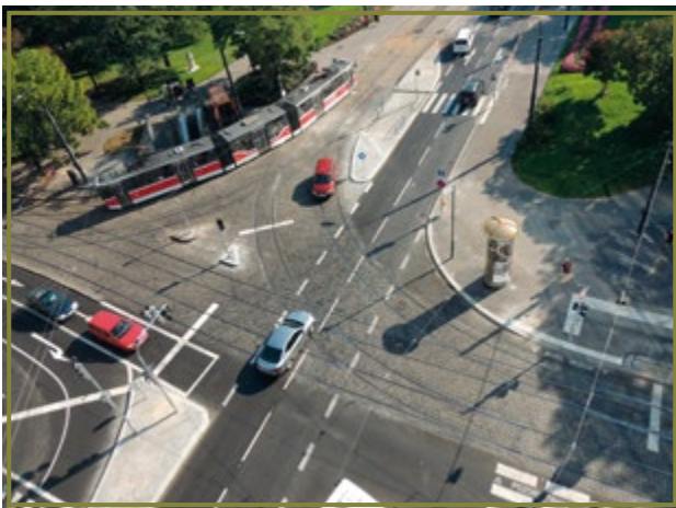
Karlovo náměstí intersection after the overhaul
