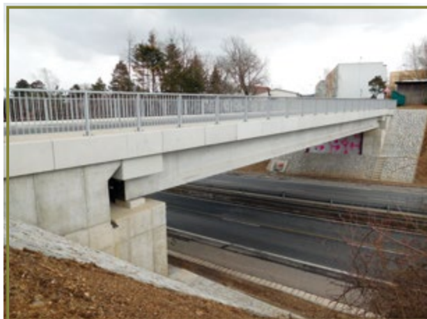
Bridge on the street K Výtopně
