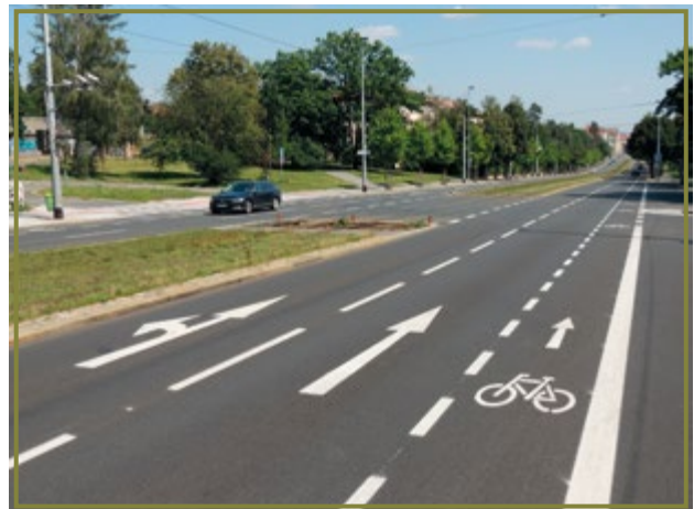
New road surfaces on Evropská
