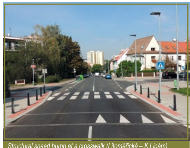
Structural speed hump at a crosswalk (Litoměřická – K Lípám)
