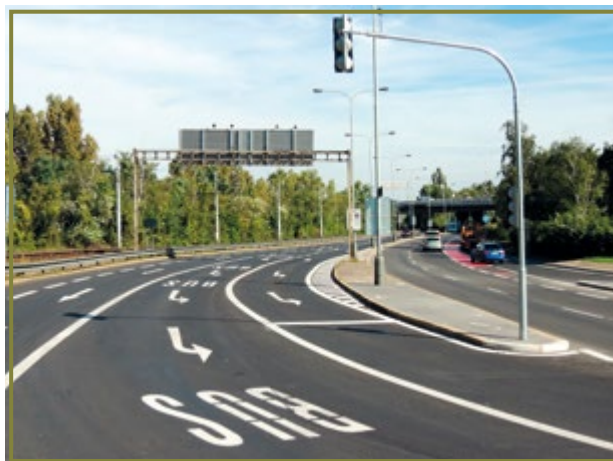
Ongoing maintenance of Modřanská
