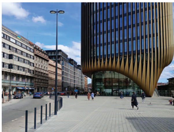
■ Ulice Na Florenci s budovou od Zaha Hadid Architects
