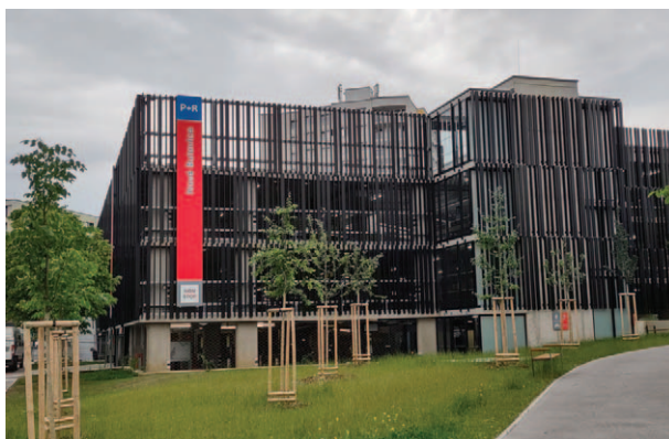
■ garáže P+R Nové Butovice
