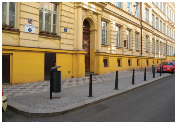
■ Úprava prostoru před ZŠ v ulici Sládkova
