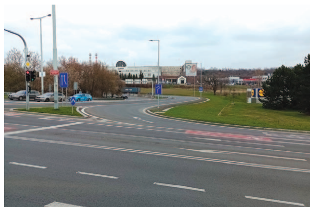
■ Nová nájezdová rampa z ulice Bucharova na Rozvadovskou spojkou
