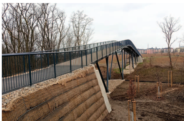
■ Lávka přes železniční trať, Čakovice
