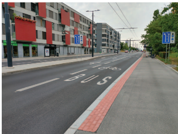
■ Ulice Prosecká po dokončené rekonstrukci
