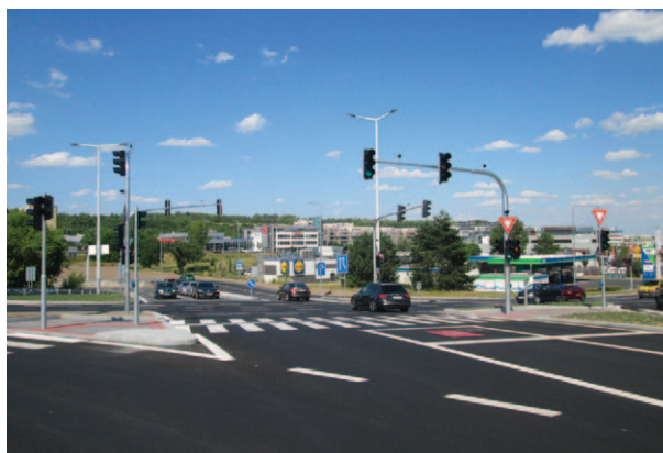
■ Obnovené SSZ 5.550 Bucharova – Nárožní
