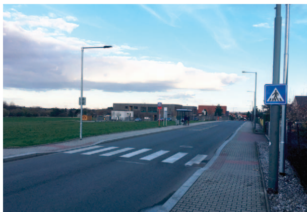
■ Nový přechod pro chodce v ulici Formanská
