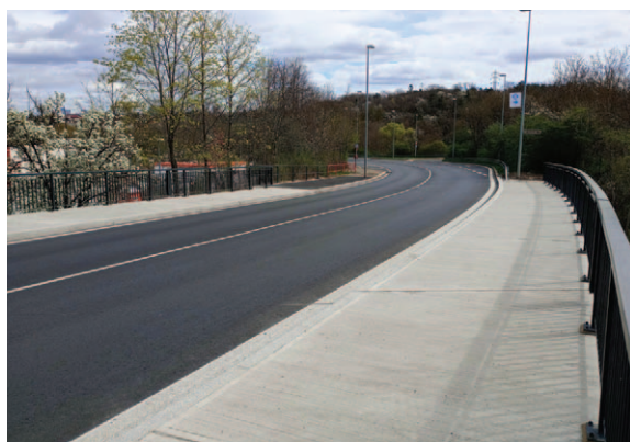
■ Most v ulici K Horkám po opravě
