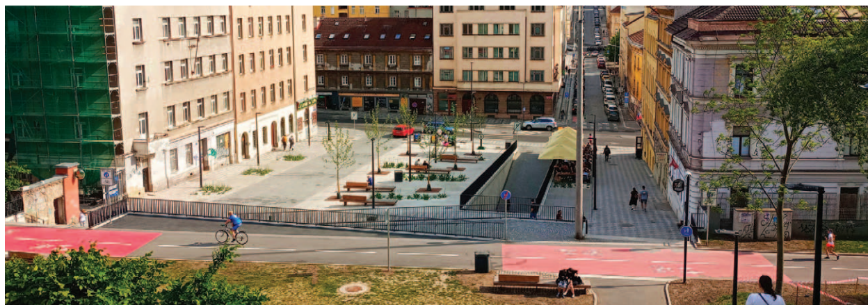
■ Tachovské náměstí po rekonstrukci
