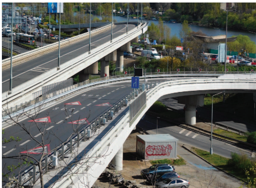
■ Opravená barrandovská rampa
