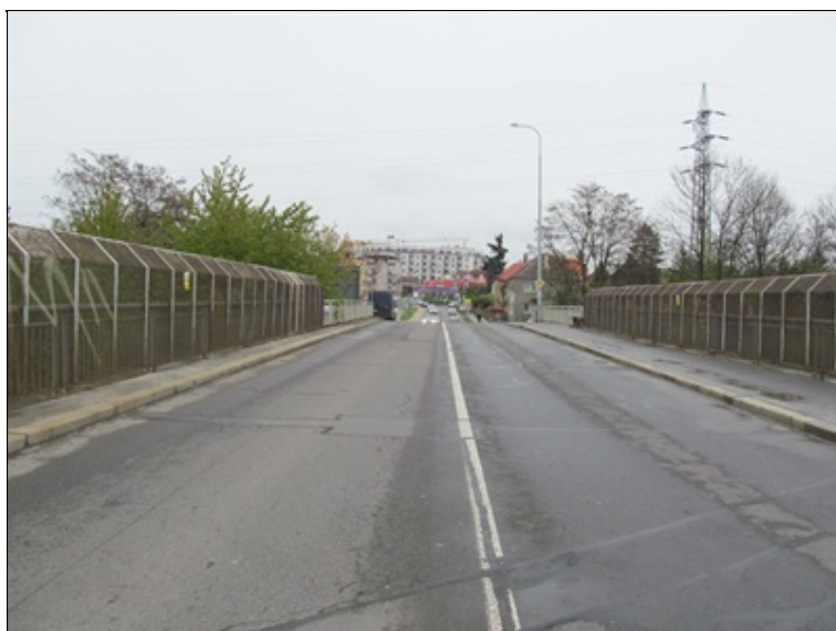
Pohled proti směru staničení.
