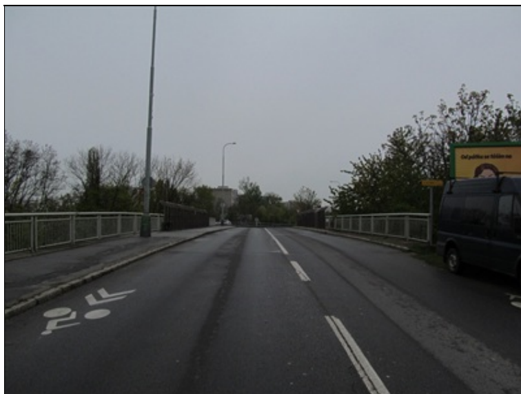
Pohled po směru staničení.
