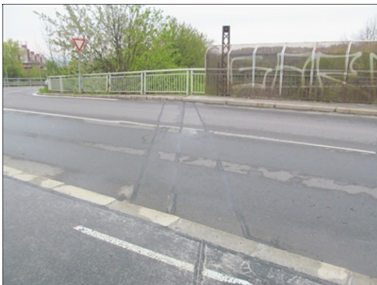
Pohled na podpovrchový mostní závěr.
