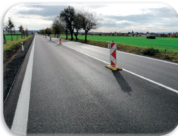
Ulice Přátelství během rekonstrukce
