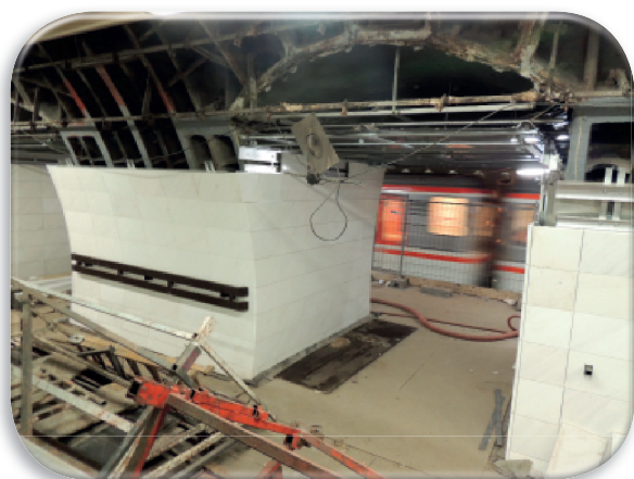
Rekonstrukce stanice Muzeum
