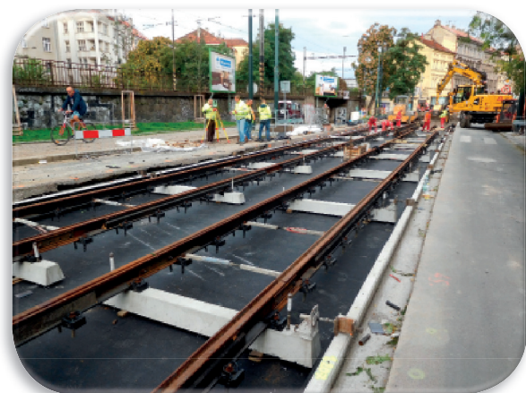
Rekonstrukce tramvajové tratě na Albertově
