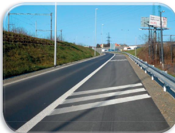
Nová sjízdná rampa MÚK Záběhlice
