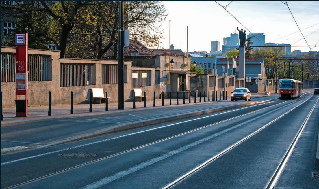
Rekonstrukce tramvajové trati v ulici U Plynárny v Praze
