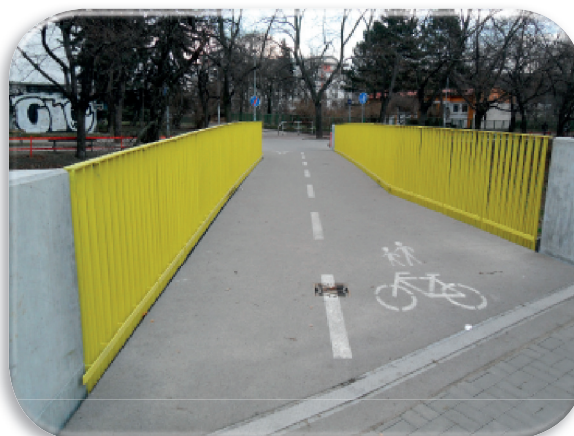
Lávka přes Botič po realizaci
