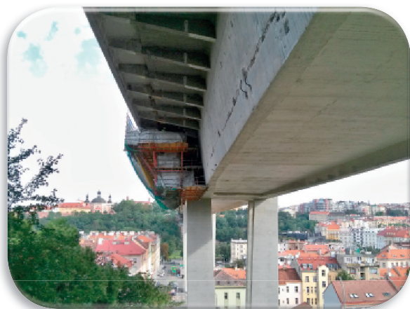
Sanace tubusu mostu ze zavěšené lávky
