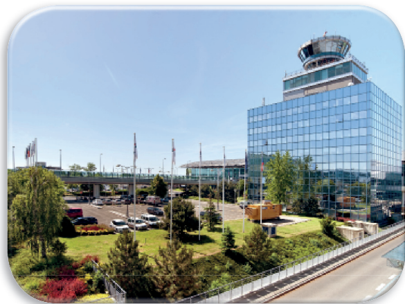
Areál Sever – věž řízení letového provozu
