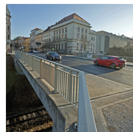
Most přes Buštěhradskou dráhu, Praha
