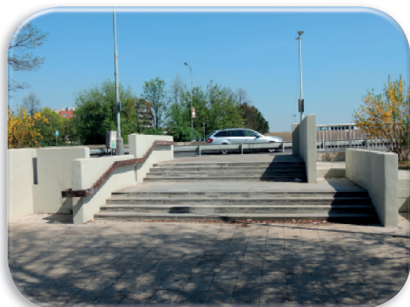
Opravené přístupy na Nuselský most
