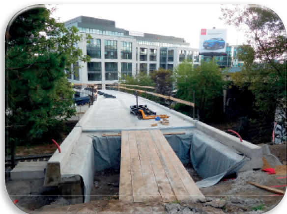
Průběh výstavby lávky
