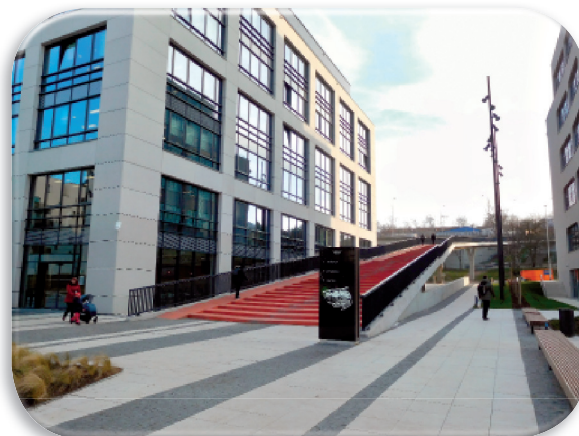
Zakončení lávky s vyrovnávacím schodištěm po realizaci
