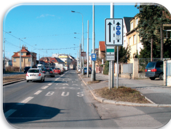
Vyhrazený pruh pro autobusy na Bělohorské ulici
