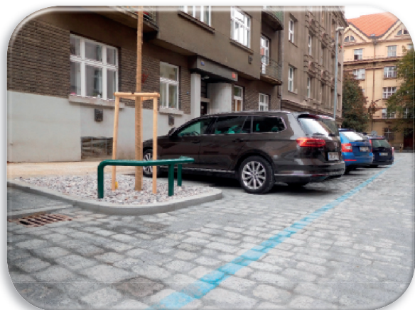
Ulice Kyjevská po rekonstrukci
