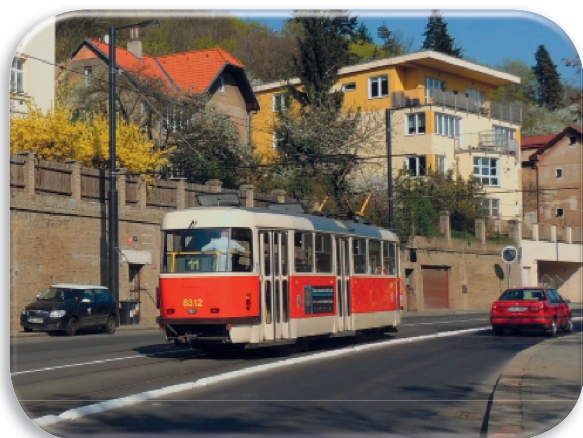
Nové tvarovky v ulici U plynárny
