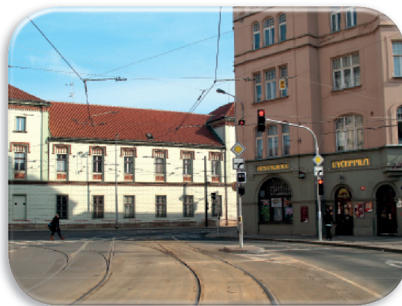
Obnovené SSZ 2.023 Svobodova – Na slupi
