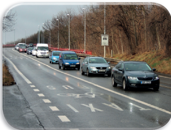
Vysočanská estakáda je znovu v provozu
