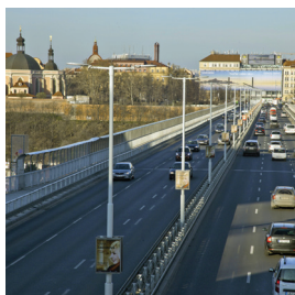
Sanace Nuselského mostu, Praha
